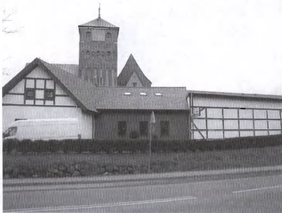
12. Darłowo, nowa zabudowa ryglowa w panoramie zamku – widok od wschodu, 2011 r.; fot. W. Witek
