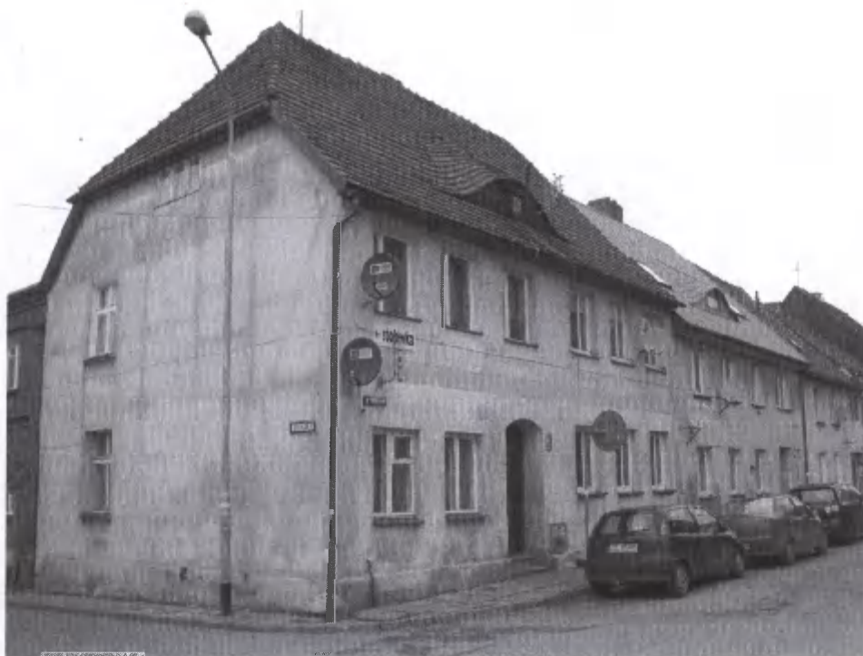
8. Darłowo, dom mieszkalny przy ul. Wenedów 11, 2011 r.; fot. W. Witek
